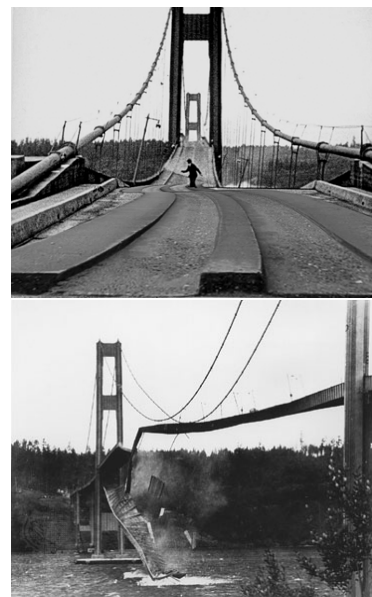
Figuur A: Instorten van de (voormalige) Tacoma Narrows brug door de wind.
